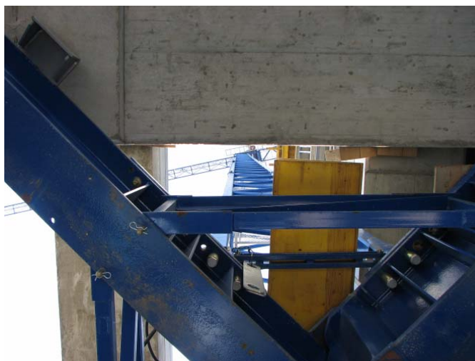
Fig. 1 – Amplasare macara la punct fix
