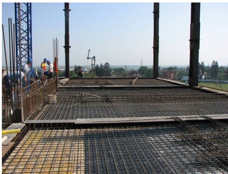
Fig. 3 – Armare planșeu nivel curent
