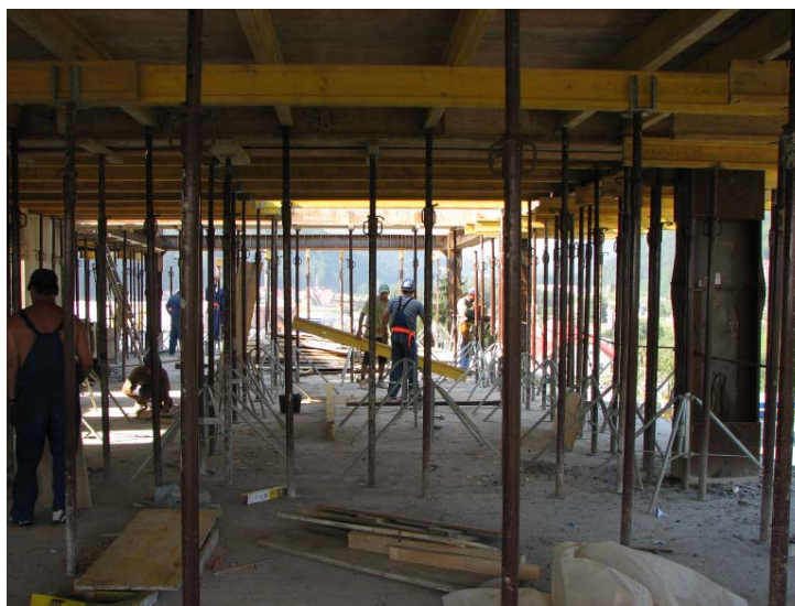
Fig. 5 – Sistem de cofraje și de susțineri
