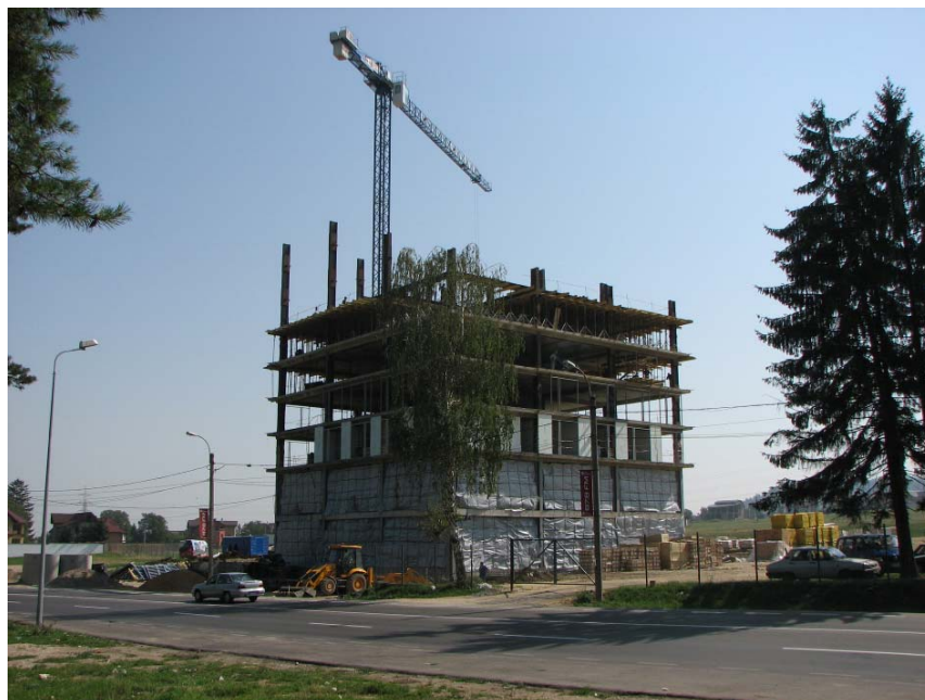
Fig. 9 – Ansamblu general șantier
