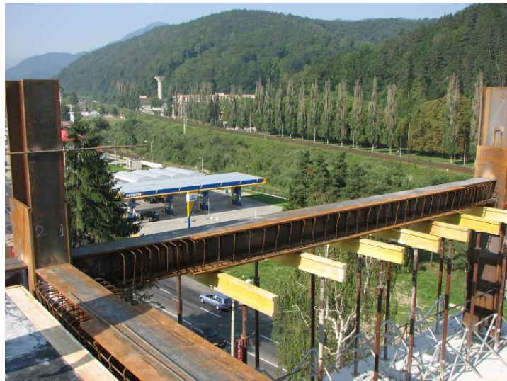
Fig. 6 – Riglă de cadru și îmbinare grindă-stâlp
