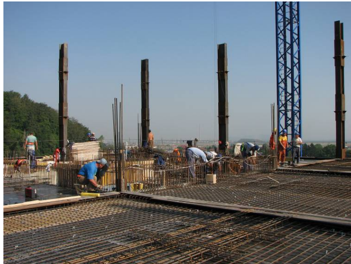
Fig. 7 – Ansamblu general armare placă nivel curent
