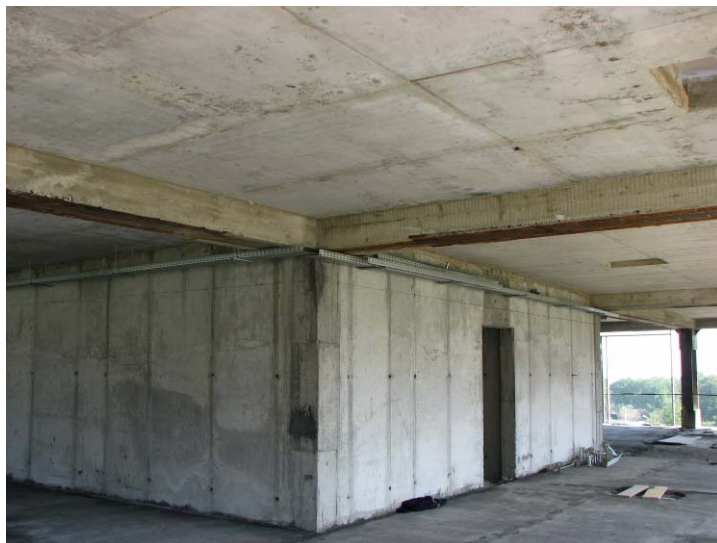
Fig. 4 – Nucleu central de rezistență
