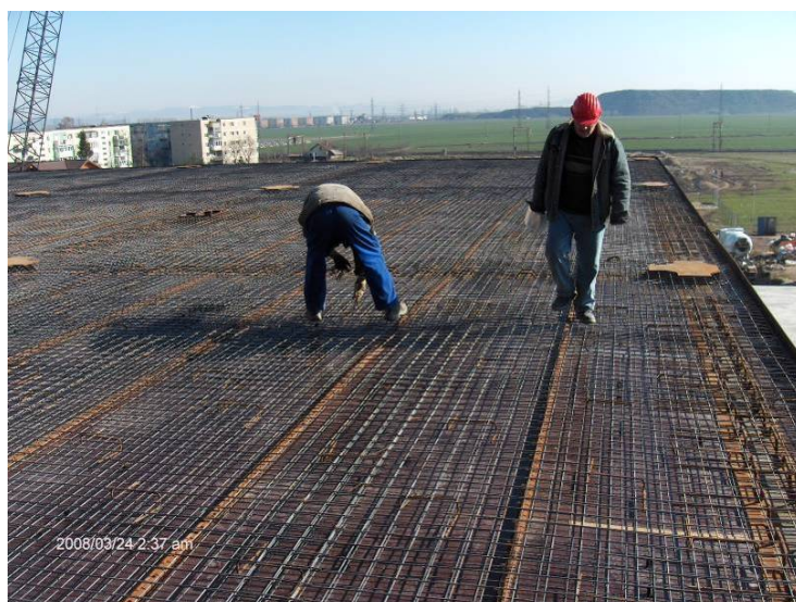
Fig. 9 – Planșeu compozit în sistem HAMBRO
