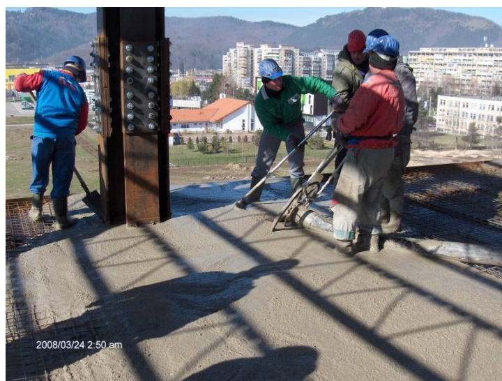
Fig. 11 – Betonare planșeu compozit în sistem HAMBRO
