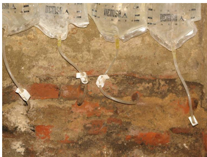
Fig. 10 – Introducere soluție hidrofobizantă
