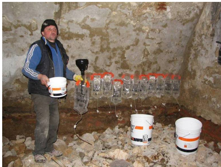
Fig. 8 – Săculețe cu soluție hidrofobizantă
