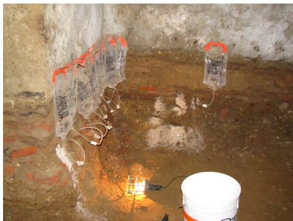
Fig. 6 – Instalarea săculețelor cu substanța hidrofobizantă
