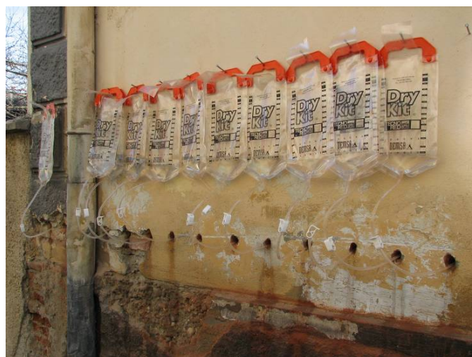
Fig. 11 – Tehnologie Drykit aplicata la exteriorul clădirii
