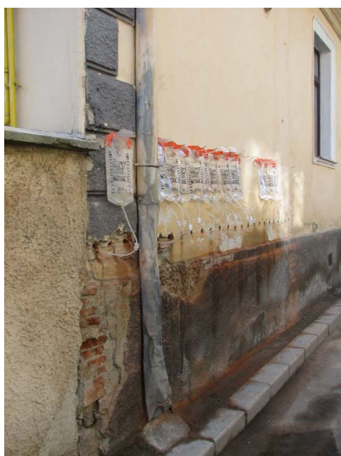
Fig. 12 – Tehnologie Drykit aplicată la exteriorul clădirii
