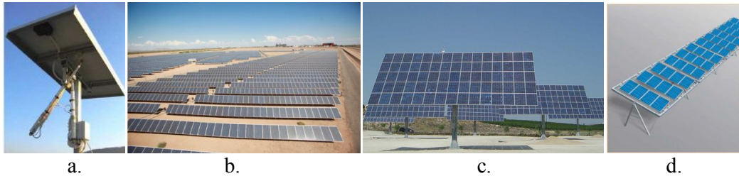
Figura 1.7. Tipuri de sisteme de orientare: a. modul individual [11], b. șiruri [109], c. platformă [110], d. platformă de șiruri [111].
