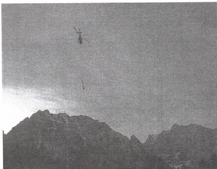
Figura 6 – Operațiune de transport spre montaj
