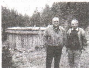
Foto 8 – Ansamblu general rezervor apă.
