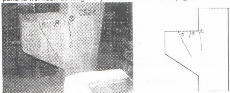
Fig. 4. Releveul fisurilor pentru console încercate până la 30 tf.
