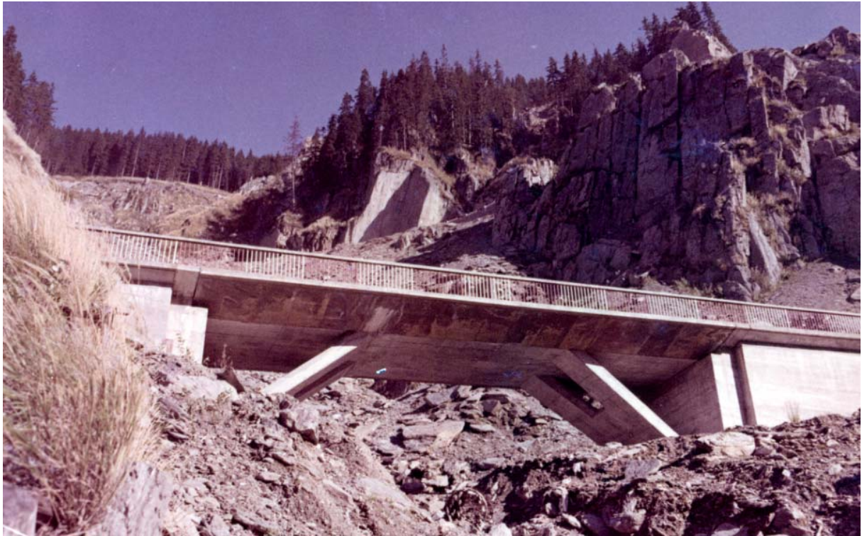
Fig. 3 Ciuta I Viaduct, km 20+600
