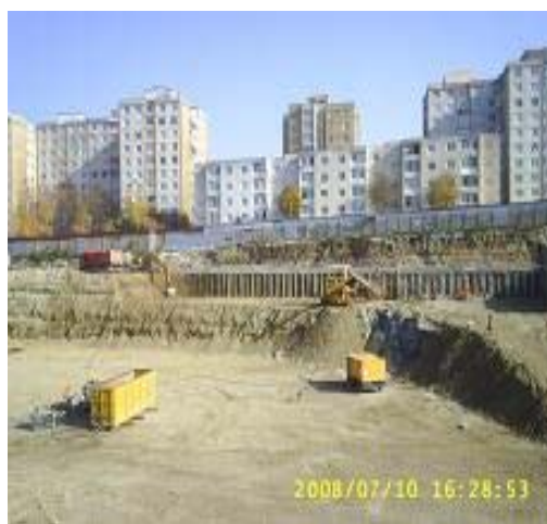
Fig.16-piloți curatați pe prima treaptă
