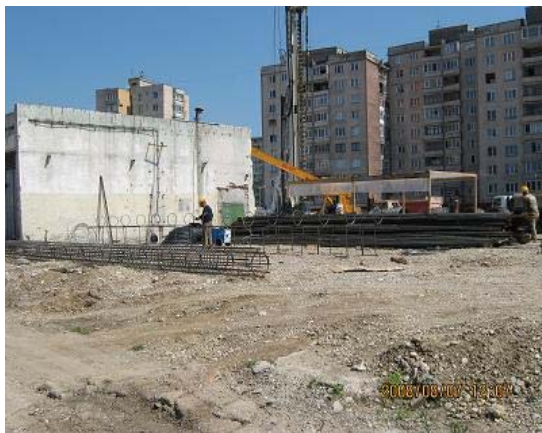
Fig.4-confecționarea carcaselor pe șantier
