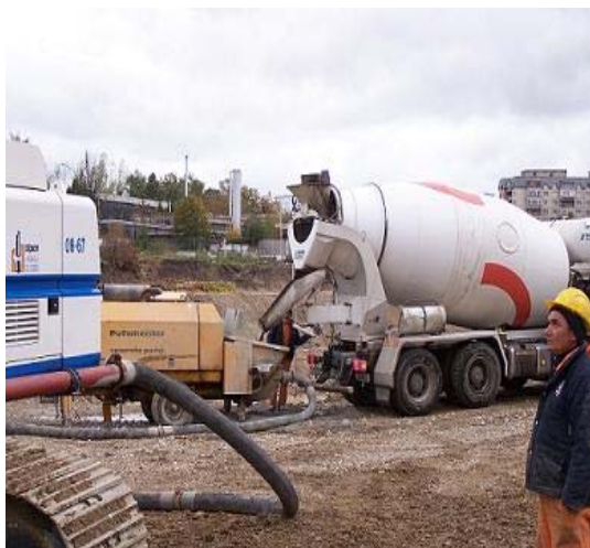
Fig.10-benonarea cu pompa de beton
