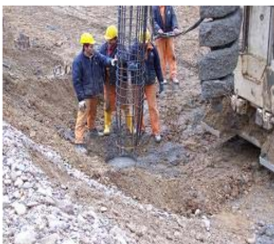
Fig.12-introducerea carcasei în beton
