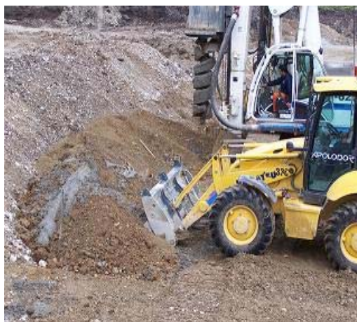
Fig.9-degajarea pământului din capul pilotului
