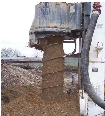
Fig.8-extragerea șneclului concomitent cu betonarea
