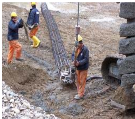
Fig.11-prinderea carcasei în mandrina vibratorului
