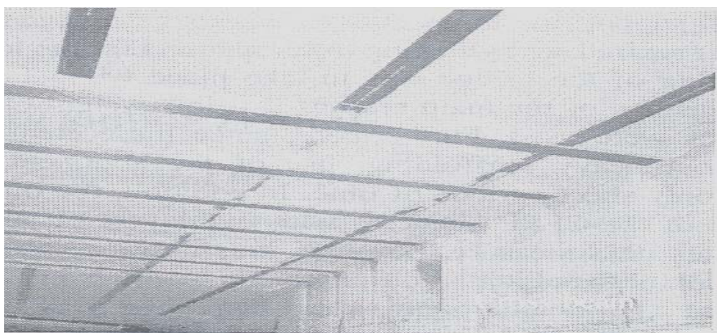
Fig.7-Consolidare cu benzi polimerice
