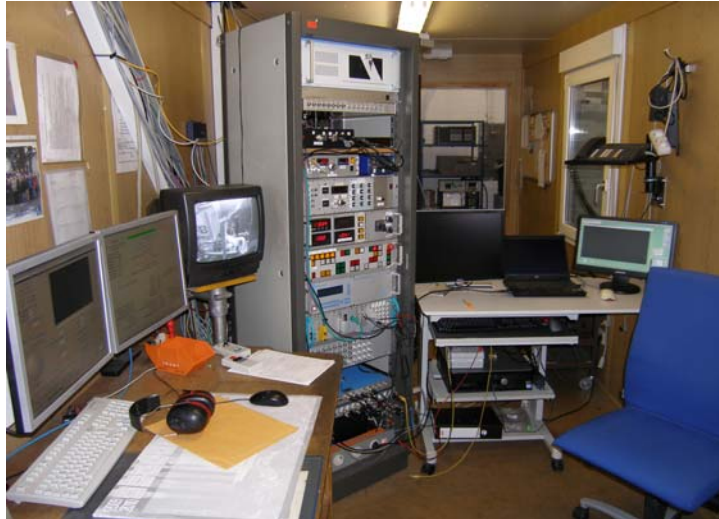
Fig. 3.1. Camera de control a standului de încercări motoare cu ardere internă
